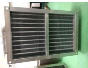
高效率熱管熱交換器
